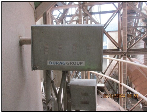
ภาพที่ 2.2 เครื่องตรวจวัดคุณภาพอากาศแบบต่อเนื่อง (CEMs)
