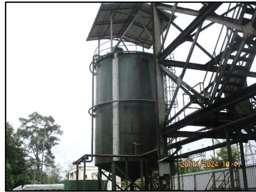
ภาพที่ 2.63 ถังเก็บของเสียที่เป็นของเหลวของโครงการ
