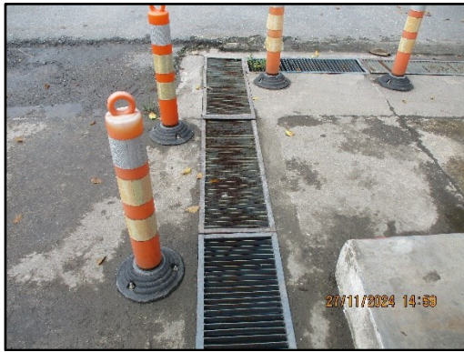
ภาพที่ 2.12 ตะแกรงดักขยะภายในโครงการ
