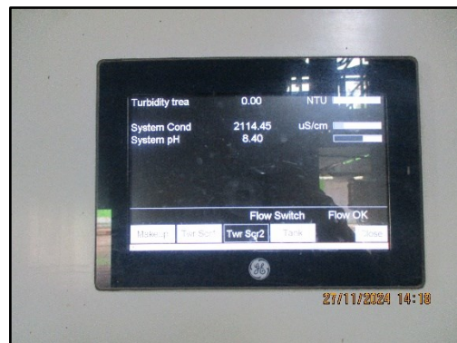
ภาพที่ 2.16 การติดตั้งเครื่องตรวจวัดคุณภาพน้ำอัตโนมัติก่อนระบายน้ำทิ้งจากหอหล่อเย็นลงสู่ บ่อพักน้ำ 200,000 ลบ.ม.
