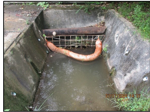
ภาพที่ 2.12 ตะแกรงดักขยะภายในโครงการ
