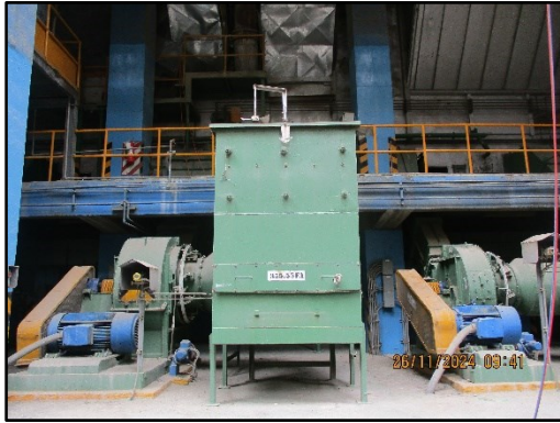
ภาพที่ 2.41 อุปกรณ์ลดเสียง (Silencer)
