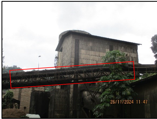
ภาพที่ 2.57 สายพานลำเลียงแบบปิดเชื่อมต่อ ระหว่างอาคารจัดเก็บ Biomass ไปยังหม้อเผา
