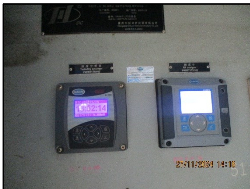
ภาพที่ 2.16 การติดตั้งเครื่องตรวจวัดคุณภาพน้ำอัตโนมัติก่อนระบายน้ำทิ้งจากหอหล่อเย็นลงสู่ บ่อพักน้ำ 200,000 ลบ.ม.
