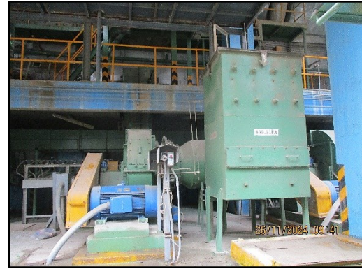
ภาพที่ 2.41 อุปกรณ์ลดเสียง (Silencer)
