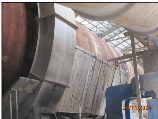
ภาพที่ 2.62 สภาพฉากป้องกันความร้อนระหว่าง Preheater กับคณงานและติดตั้งกรงเหล็ก
